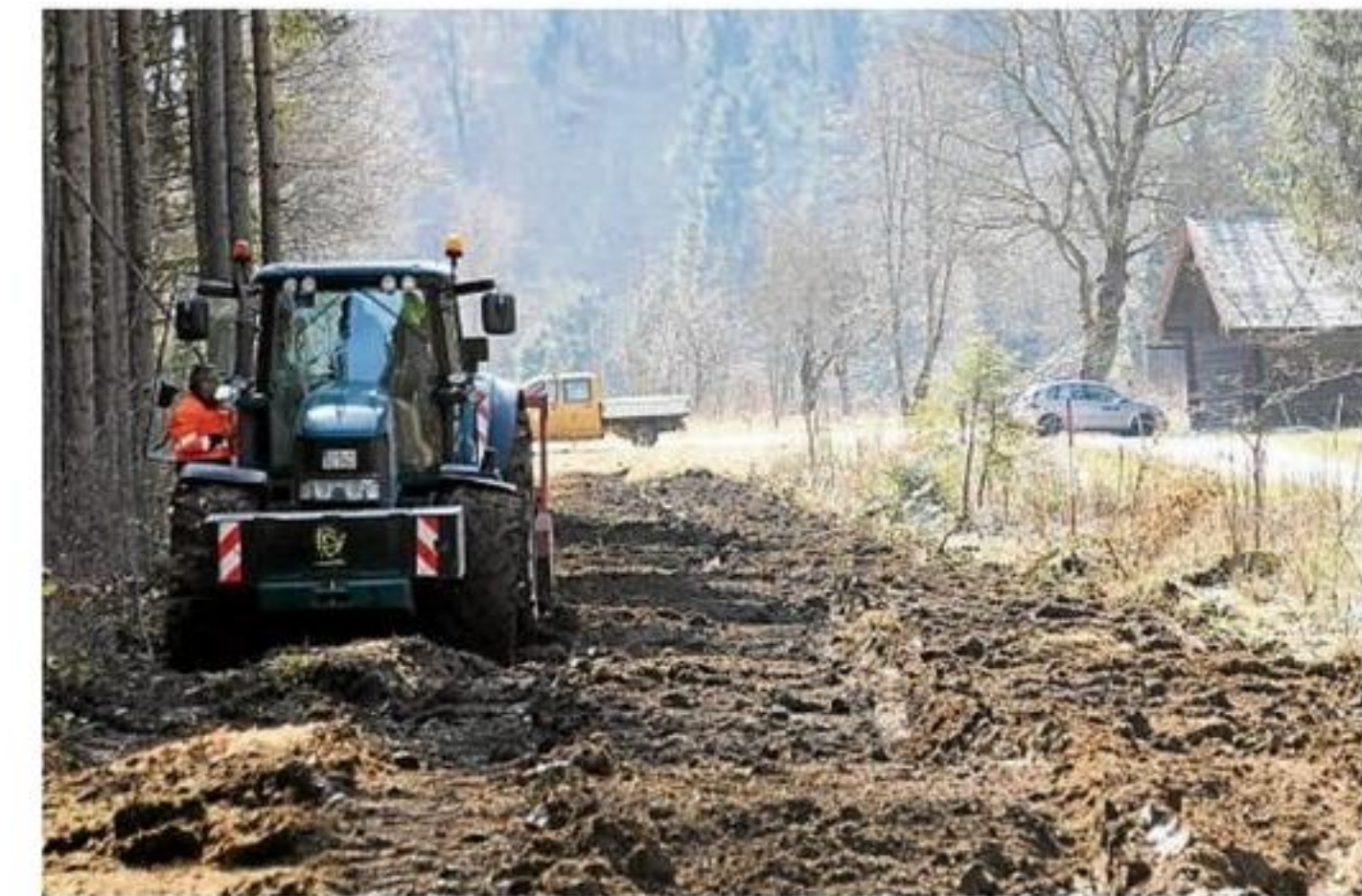
Buddeln für die neue Leitung: Die Stadtwerke München verlegen bei Thalham derzeit neue Rohre. Das Bild entstand zu Beginn der Bauarbeiten.
