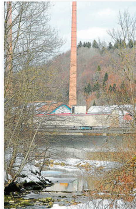
Der Knackpunkt: Die Unterdükerung der Mangfall bei Müller am Baum gefällt den Stadtwerken nicht.
